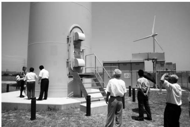
塔の高さ80m、羽根の半径40mの巨大な風力発電機、11基ある
