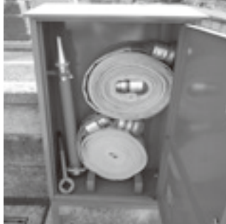
初期消火の決め手は消火栓!!
