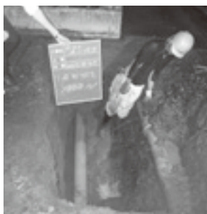
配水管修繕により有収率向上 (北部簡易水道地区内)
