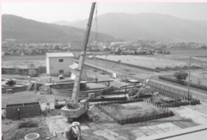
池田浄化センター増設工事
