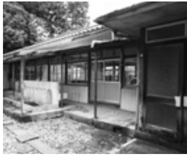
取り壊された昔の宮地保育園園舎
