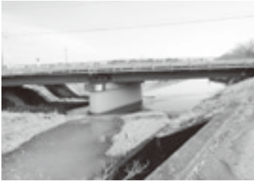
調査が進む更田橋 (片山地内)
