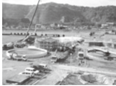
着々と増設工事が進む池田浄化センター
