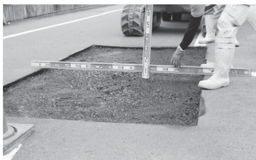
舗装復旧工事(本郷地内)
