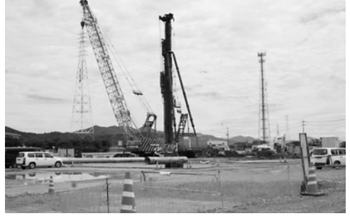
着々と工事が進む共同学校給食センター
