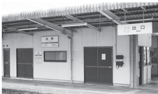
改修計画がある池野駅舎
