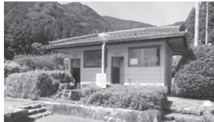
改修が望まれる大津谷公園トイレ
