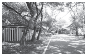
コンクリート造の霞間ヶ溪公園トイレ
