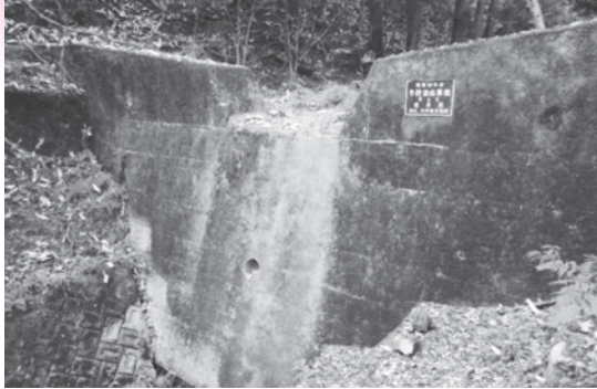
金地谷堰(えん) 堤
