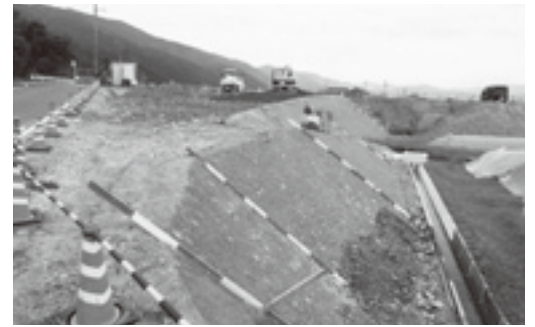
路線認定され工事が進む片山北72号線(南側より)
