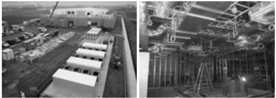
着々と工事が進む共同学校給食センター
