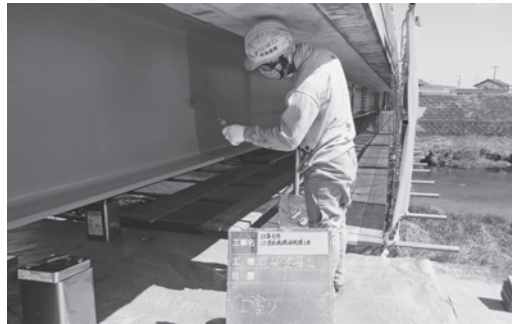
橋梁の塗装工事(下地調整した後、3層塗られる)
