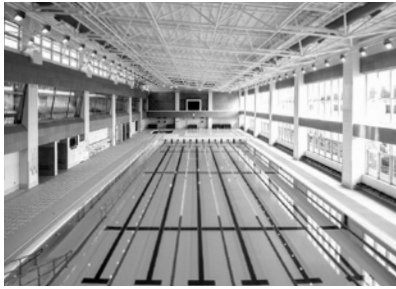
屋内温水プール
