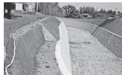
高低差 4.22m 転落防止対策を（金地谷）
