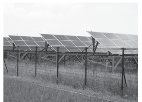
太陽光発電設備(片山南地区)
