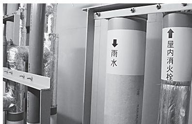
雨水をトイレ洗浄水に
