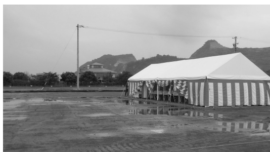
建設現場 北より
