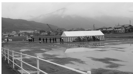
建設現場 東より
