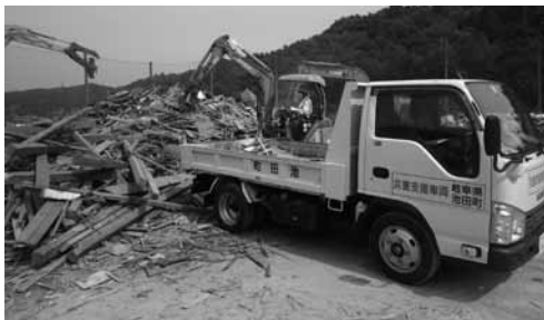
現場での作業の様子
