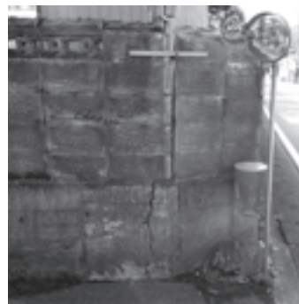
ヒビ割れ傾いたブロック塀
