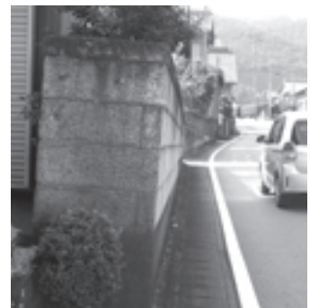
傾いたブロック塀
