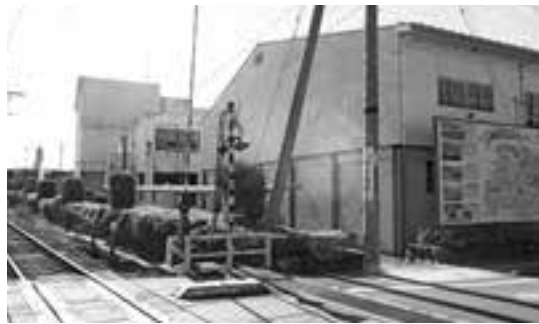
多目的ホールの東側より
