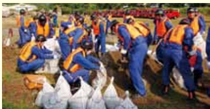
土のう拵え工
