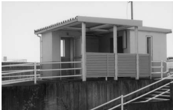
南部公園トイレ
