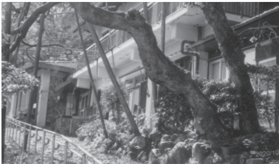
池田町霞ヶヶ深さくら会館
