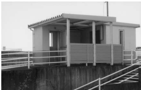
南部公園トイレ
