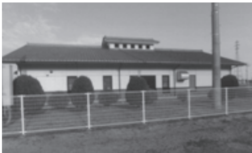
農業集落排水処理施設
