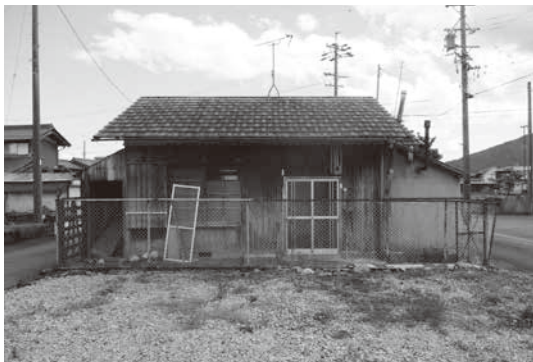
取り壊し予定の田中住宅
