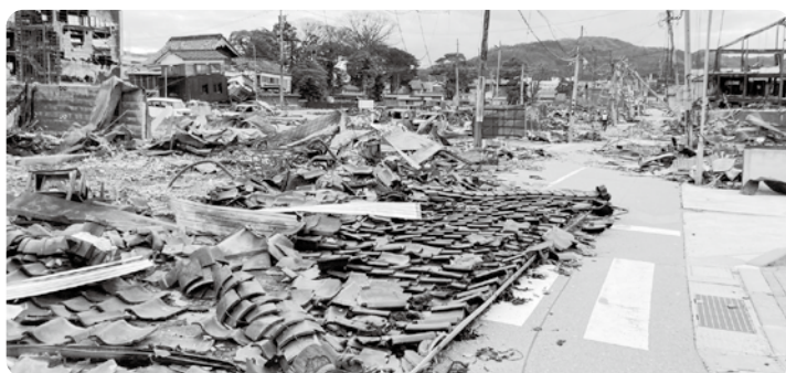
道路被害の状況（町派遣職員撮影）
