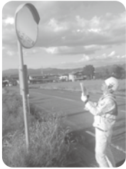
カーブミラー 点検の様子
