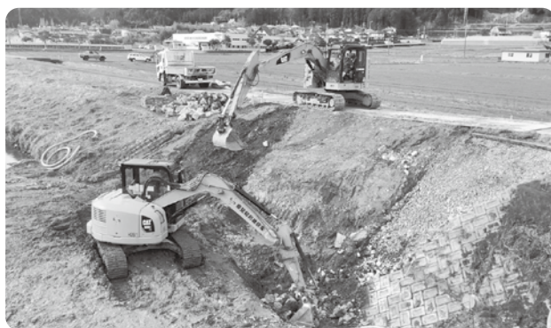
杭瀬川の護岸工事（藤代地内）
