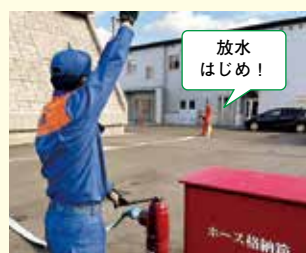
ホース結合！ 消火栓ハンドルを付ける
