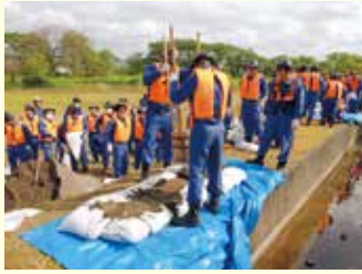
▲積み土のう工の実施
