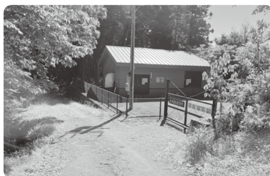
宮地清流発電所
